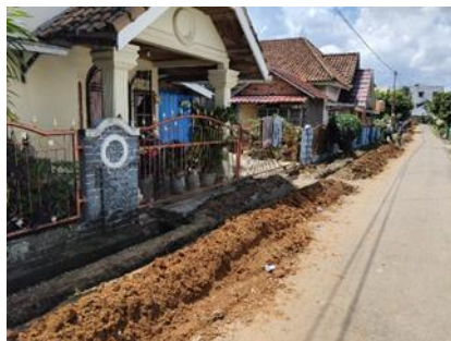
Gambar 3.3 Dokumentasi kegiatan Pengembangan Jaringan Pipa Distribusi Kabupaten Lahat
