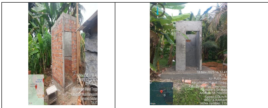
Gambar 3.2 Dokumentasi kegiatan Penyediaan Sub Sistem Pengolahan Setempat di Kawasan Strategis Provinsi Sekayu dan Sekitarnya
